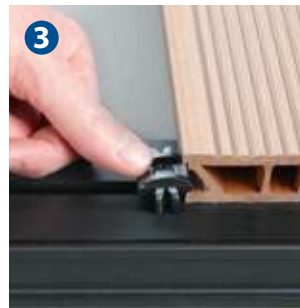
Zur weiteren Montage der Dielen Montageclips einfügen – ohne zu schrauben!
