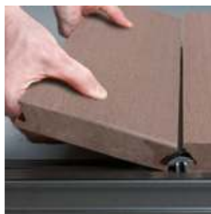
Anfangsclip auf der Unterkonstruktion festschrauben und erste Bodendiele einrasten.
