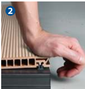
Anfangsclip auf der Unterkonstruktion festschrauben und erste Bodendiele einrasten.
