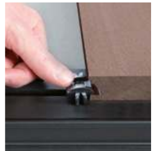
Zur weiteren Montage der Dielen Montageclips einfügen – ohne zu schrauben!
