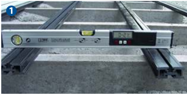
Untergrund vorbereiten und Unterkonstruktion befestigen.
